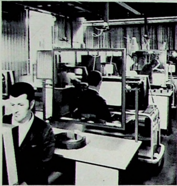
In einer vom eigentlichen Prüffeld abgetrennten Anlage, dem Konvergenzkeis, wird die exakte Konvergenzeinstellung vorgenommen
